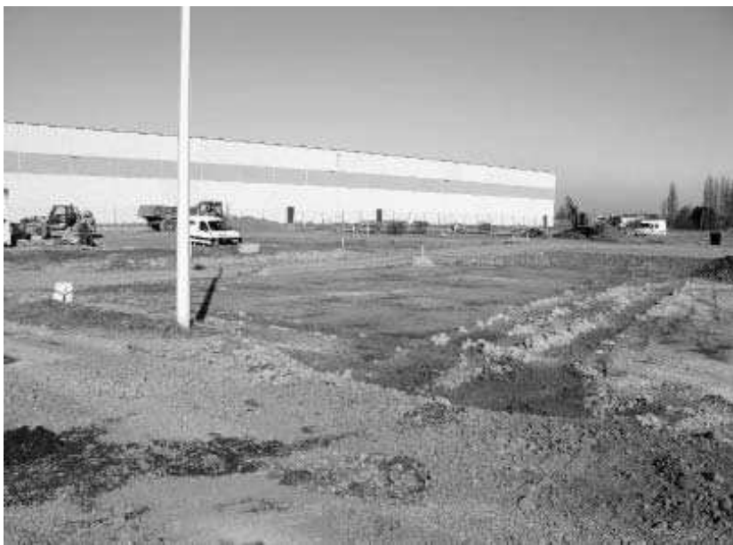
A l'arrière de l'entreprise L&O, les travaux de construction du nouveau bâtiment avancent.
