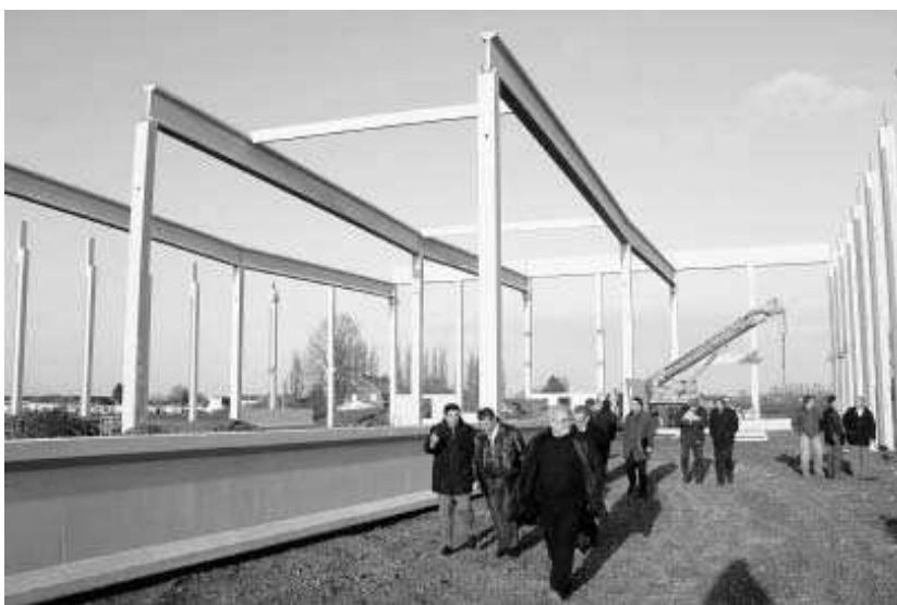
La construction du bâtiment a débuté au début du mois de février et doit être terminée pour le 31 mai !
